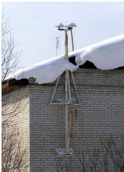
Рис. 2. Антенна станции IGS NSKV
